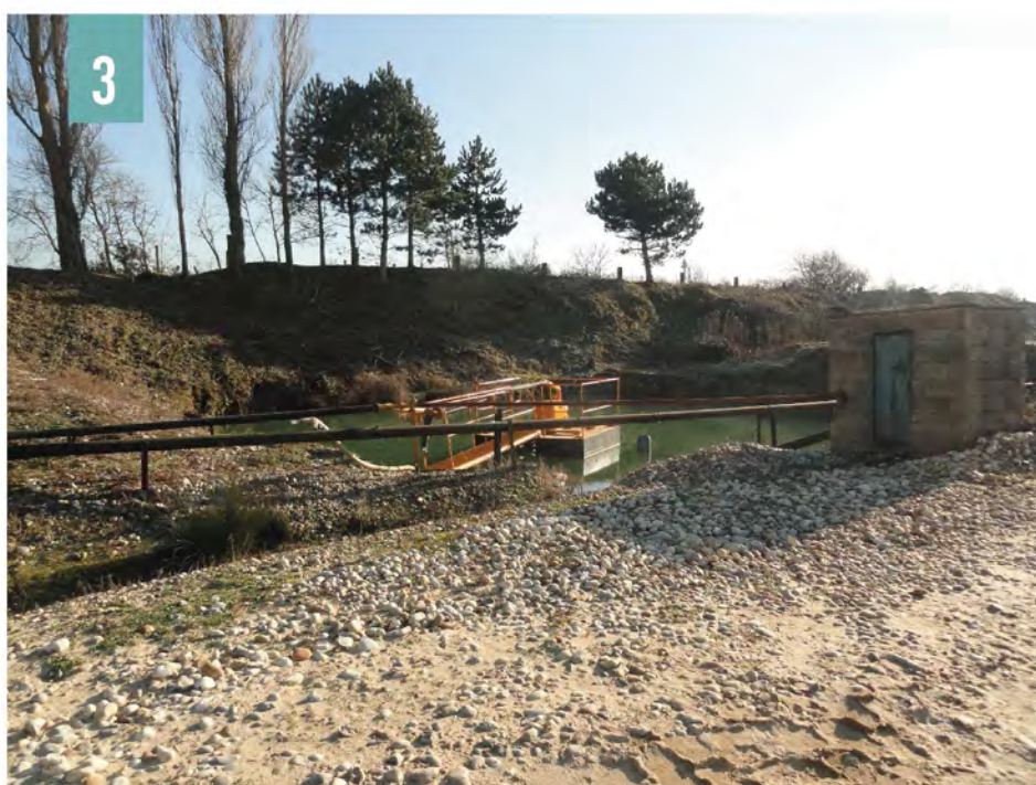
Bassin de pompage des eaux de lavage
